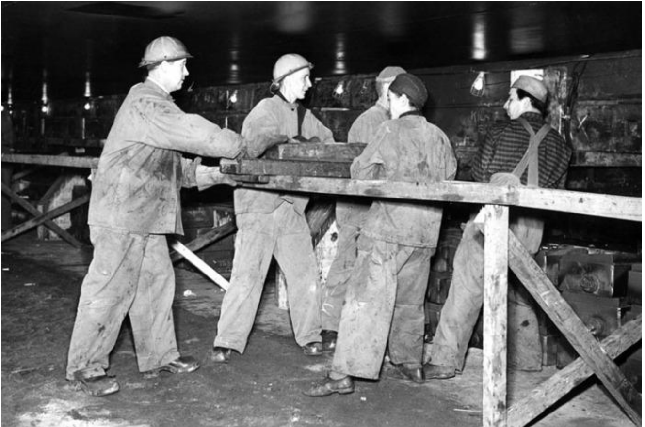
Inför sjösättning - kilning med "tjur" vid avlöpningsbana.
