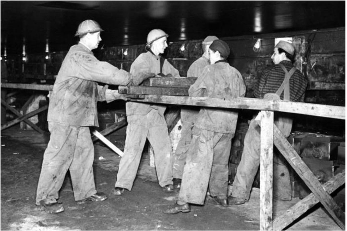
Inför sjösättning - kilning med "tjur" vid avlöpningsbana.
