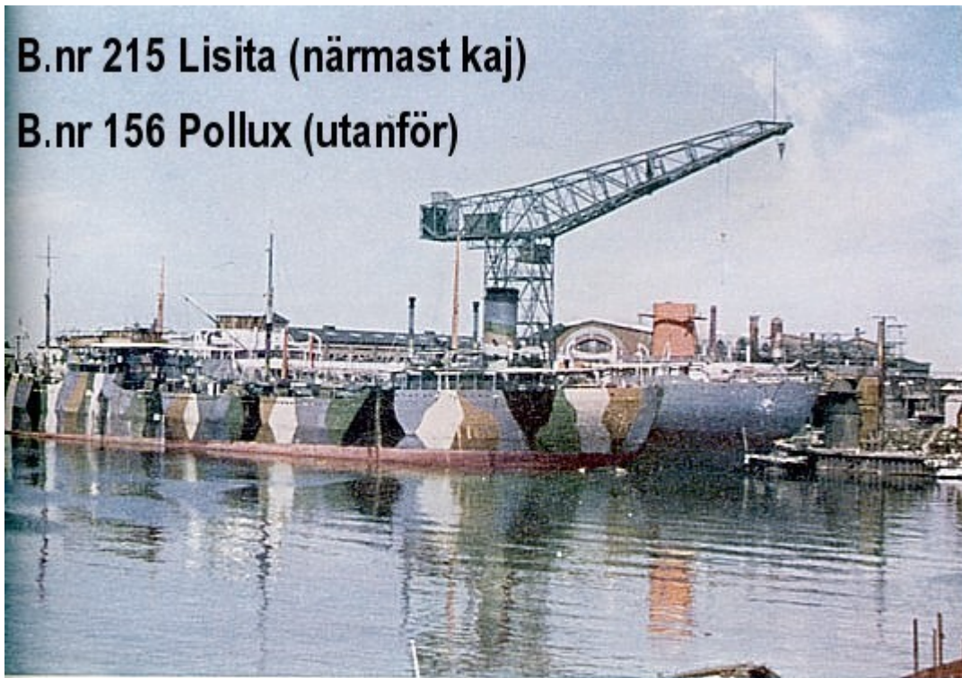
Varvsbassängen och utrustningskajen 1 juli 1940.
