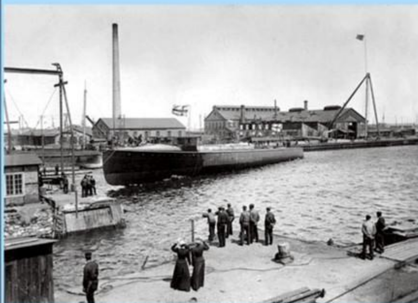
Bilden från före 1908 Jagaren Vale B.nr 92. 346 tons displacement och maskinstyrka 7200 hkr. Byggd till Svenska Marinen. Levererad 1908. På bild ses fartyget under sjösättning. I bakgrunden verkstäder och utrustningskran.
