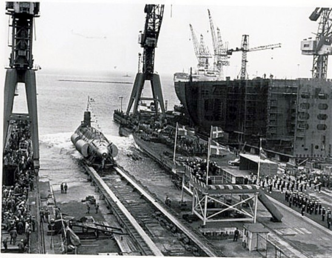
Sjösättning! Sjölejonet på väg ut under kranarna. Skådespelet utspelar sig den 29:e juni 1967.
