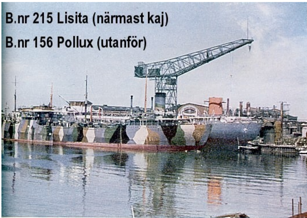
Varvsbassängen och utrustningskajen 1 juli 1940.
