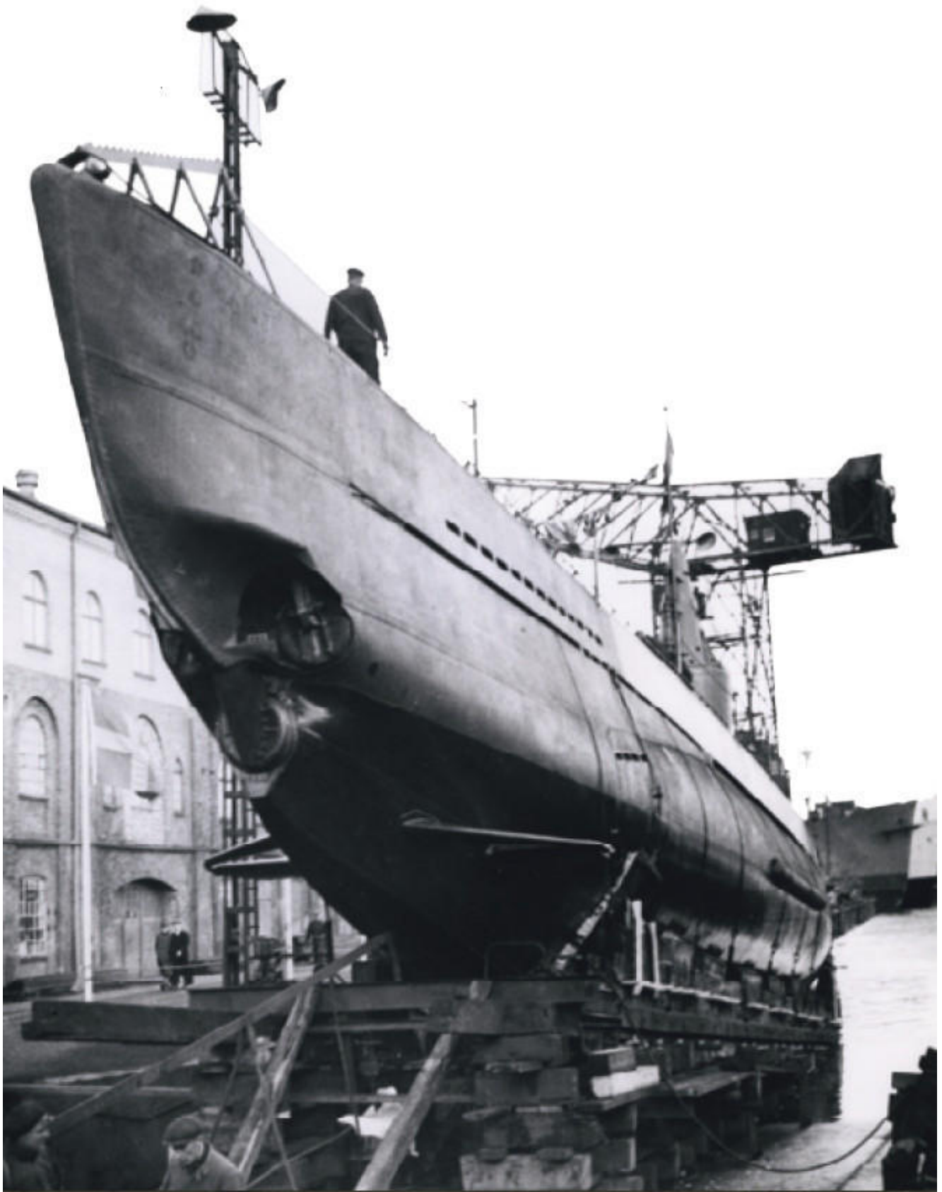
Ubåten U 7, en av de s k nummerbåtarna. Levererades 1944. Byggses sedan om på Karlskronavarvet till jaktubåten
